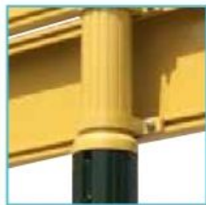
Collerette. Jonction de mât à rehausse.
